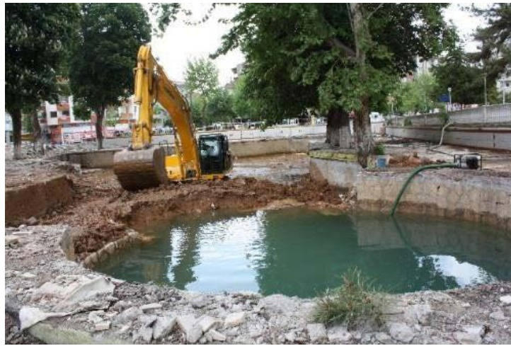
Şekil 5.Kernek Şelalesi Bakım ve Onarım Çalışması
