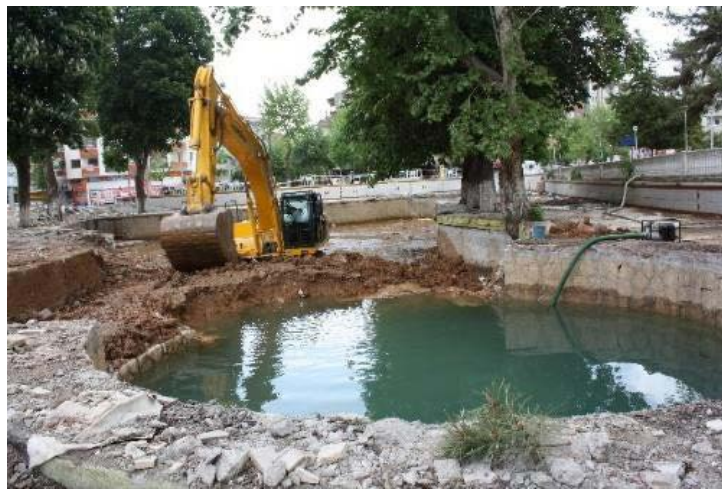
Şekil 5.Kernek Şelalesi Bakım ve Onarım Çalışması
